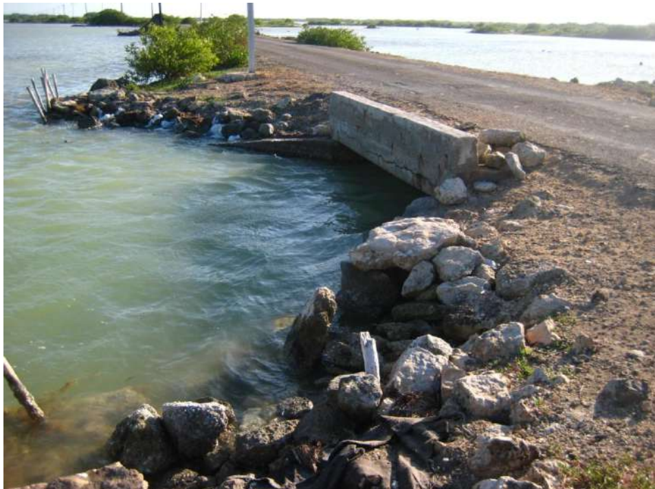
Foto 5. Alcantarillas en la carretera norte-sur. Puerto Tabché.
