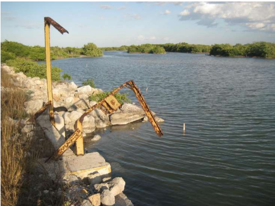
Foto 9. Antiguas compuertas en la carretera costera. Puerto Tabché.
