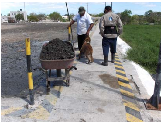
Remoción de material flotante en las lagunas de oxidación
