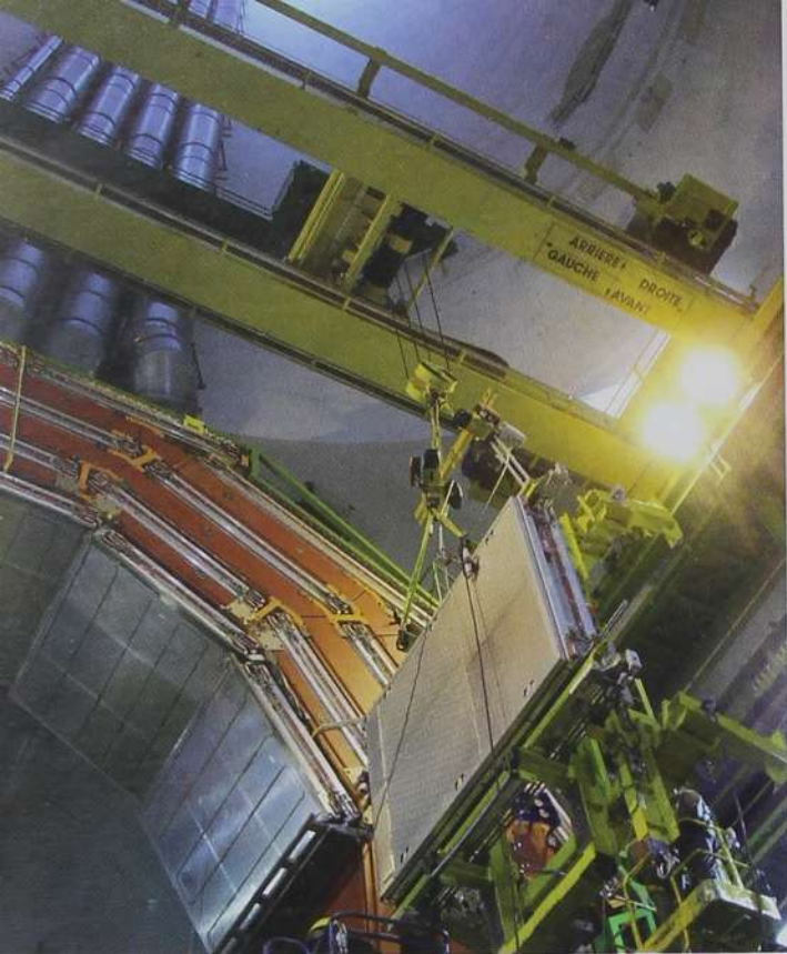
Descenso de equipos a la caverna.
