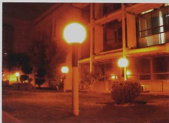
Figura 31. Lámparas de vapor de sodio usadas en Cinvestav-Zacatenco.
