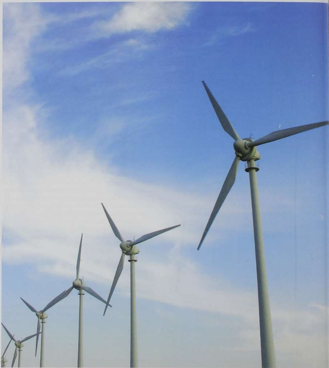
Fig. 3. Aerogeneradores de la central eólica La Venta.
