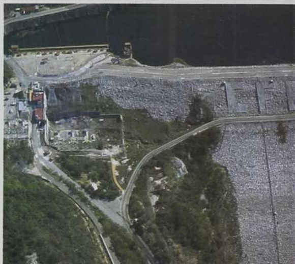
Fig. 1. Vista aérea de la cortina desde aguas abajo central hidroeléctrica Chicoasén.
