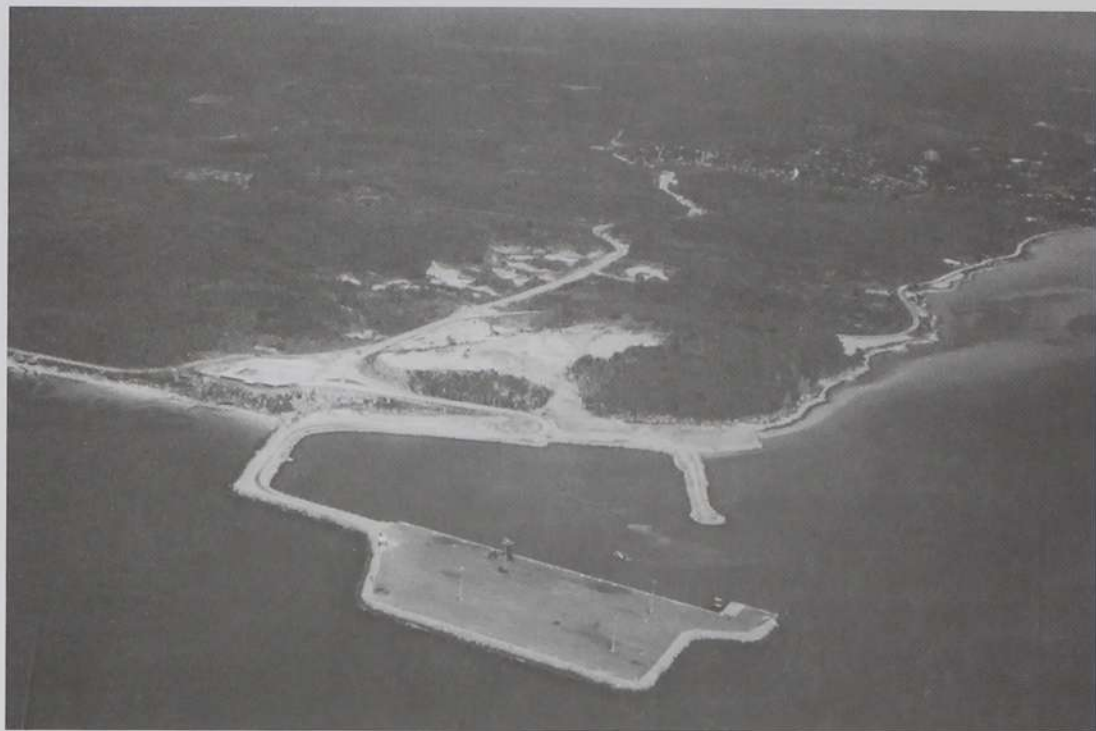
Infraestructura portuaria en costas de la Península de Yucatán.
