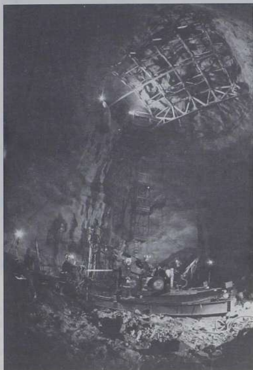
Figura 2. Construcción de la cavidad para alojar el detector SNO.
