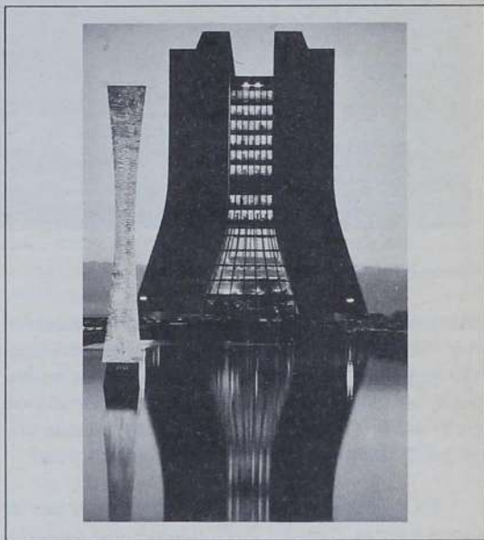
Edificio principal del Fermilab
