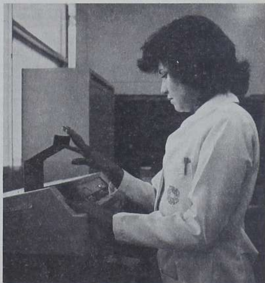
La planta cuenta con un pequeño laboratorio donde se realizan análisis microbiológicos y químicos. En este espectrofotómetro se sigue el crecimiento celular desarrollado en los fermentadores.
